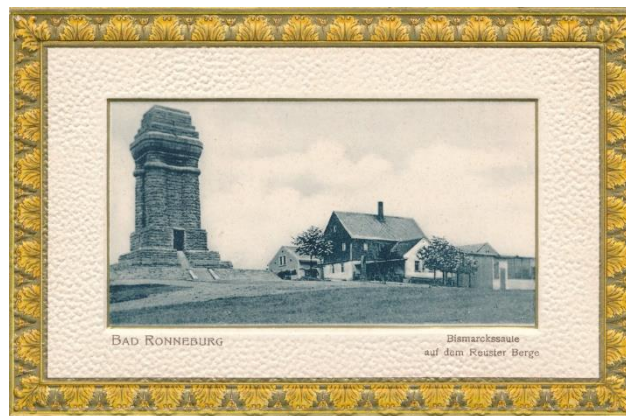
Bad Ronneburg Bismarckssäule auf dem Reuster Berge
